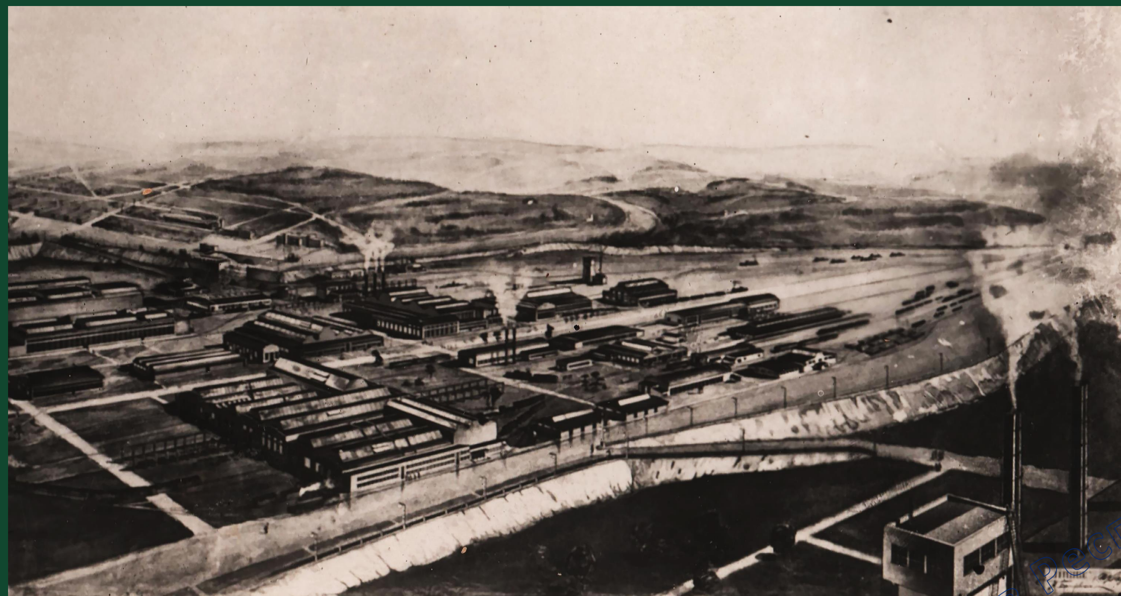
Панорама строительства ПВРЗ. Без даты. Фотофонд ГАРБ
